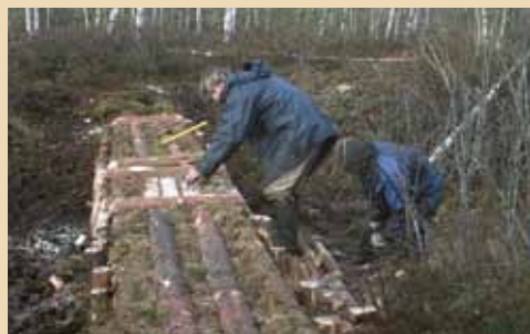
57. attēls. Aizsprosta virskārtas nostiprināšana ar diviem aptuveni 15 cm resniem priedes baļķiem un šķērslatām dabas lieguma „Lubāna mitrājs” Salas purvā
