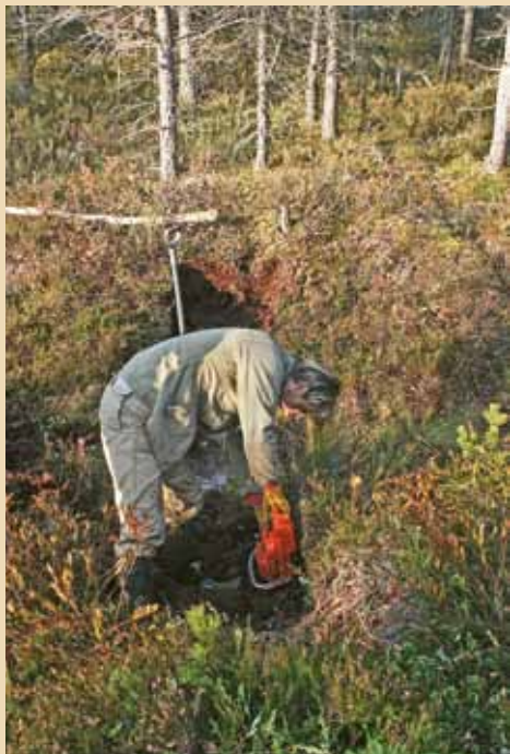
50. attēls. Aizsprosta profila izzāgēšana ar motorzāģi dabas lieguma „Lubāna mitrājs” Klajotnes purvā, fotoattēlā Valdis Cīrulis
