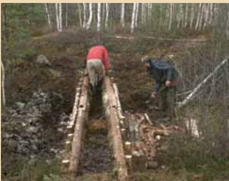
55. attēls. Ar vertikāli iedzītu pāļu barjerām nostiprināts divrindu aizsprosts un ieklāto sfagnu/kūdras sablīvēšana dabas lieguma „Lubāna mitrājs” Salas purvā
