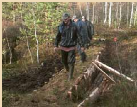
56. attēls. Aizprostā ieklāto sfagnu sablīvēšana dabas lieguma „Lubāna mitrājs” Salas purvā
