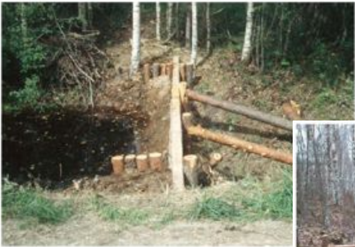
Divās rindās horizontāli novietotu baļķu aizsprosts ar kūdras pildījumu, Teiču
