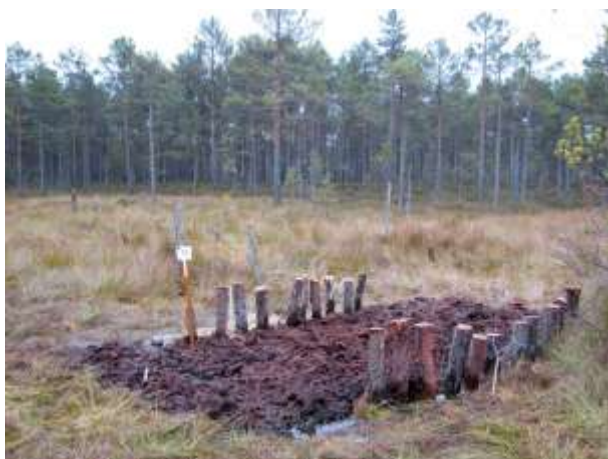
Peat/wood dam in Aizkraukle Mire on 16.10.2012.
