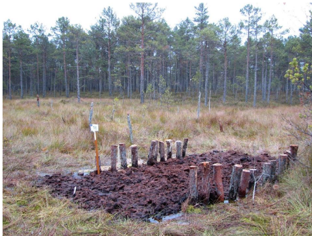
Peat/wood dam in Aizkraukle Mire on 16.10.2012. Photo: Gunars Balodis
